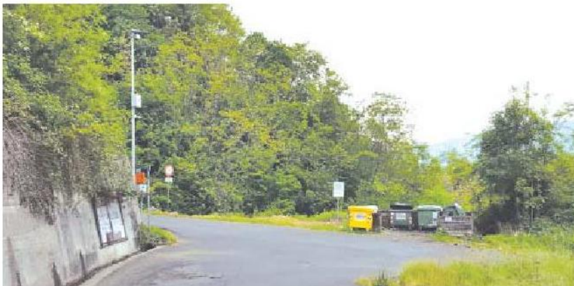
Controlli anche sull'isola ecologica verso la frazione Mombracco
