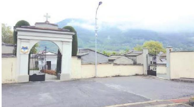
Telecamera sistemata nei pressi dell'ingresso del camposanto del capoluogo
