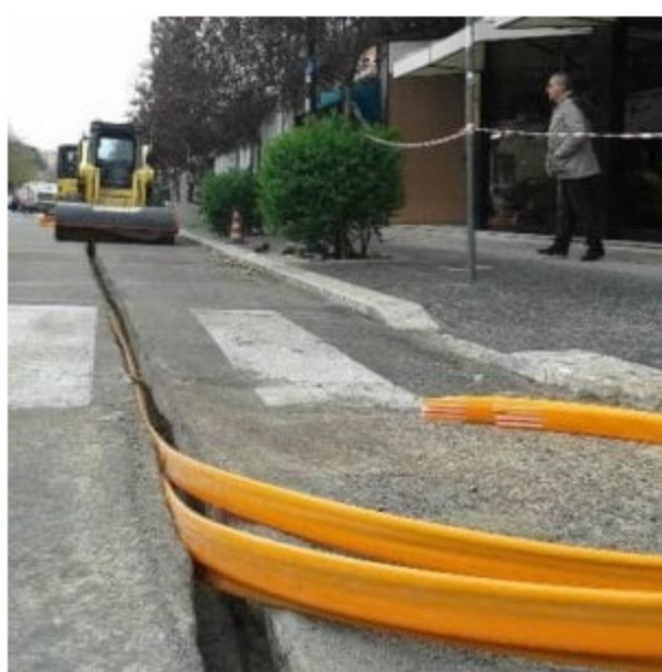
La posa di una rete in fibra ottica
