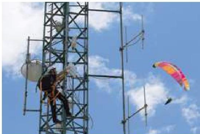
L'installazione di un trasmettitore internet su un traliccio
