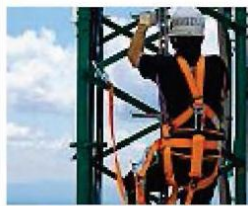
Tralicci L'alternativa alla rete via cavo
